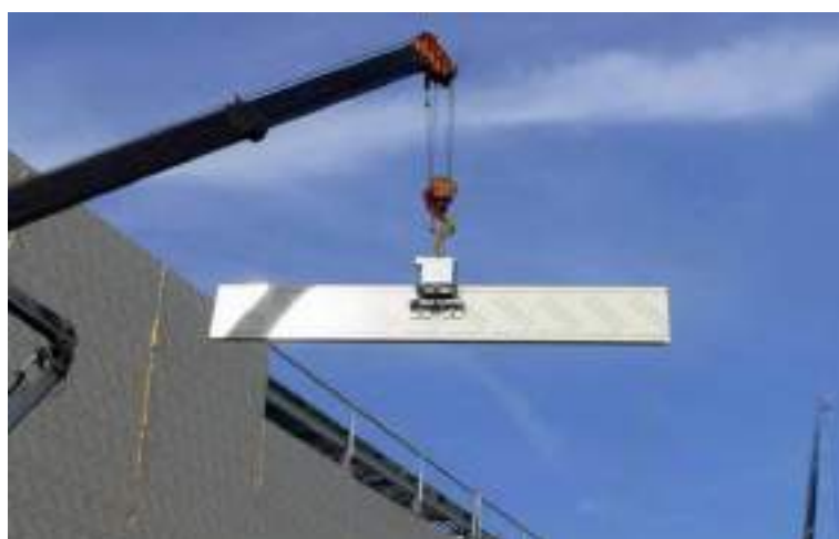
Рис. 9.8.2. Схема строповки сэндвич-панелей
