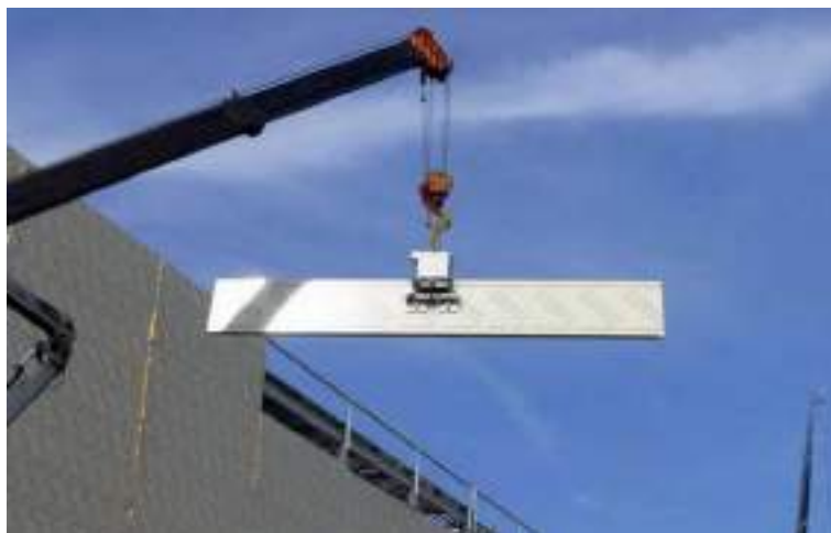
Рис. 9.7.2. Схема строповки сэндвич-панелей
