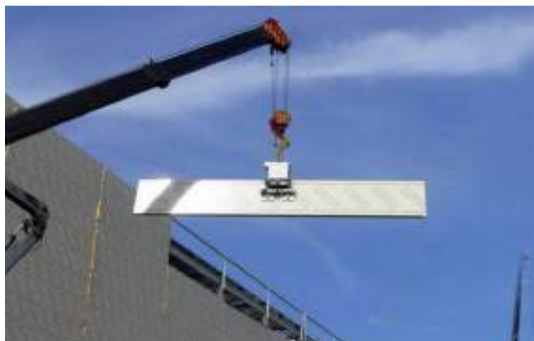
Рис. 5.9.1. Вакуумные захваты для сэндвич-панелей
