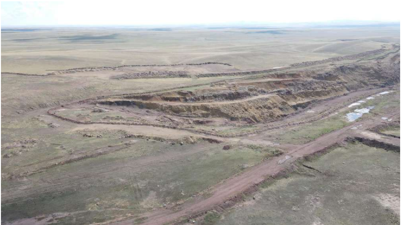
Рисунок 6.1.1 – Карьерная выемка и отвалы вскрышных пород в русле и в водоохранной зоне притока №1 реки Узынбулак
