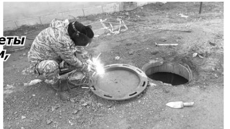
А всё потому, что люки не были азбетонированы во время проведения водопровода.
