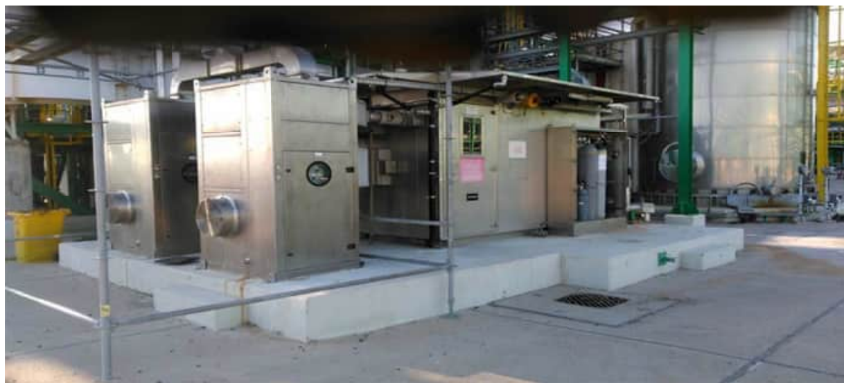
Рисунок 1.4.1.-3. Существующий блок-бокс анализатора A1-3321-JA-002 вид спереди
