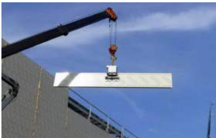
Рис. 5.9.1. Вакуумные захваты для сэндвич-панелей
