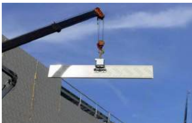
Рис. 9.8.2. Схема строповки сэндвич-панелей
