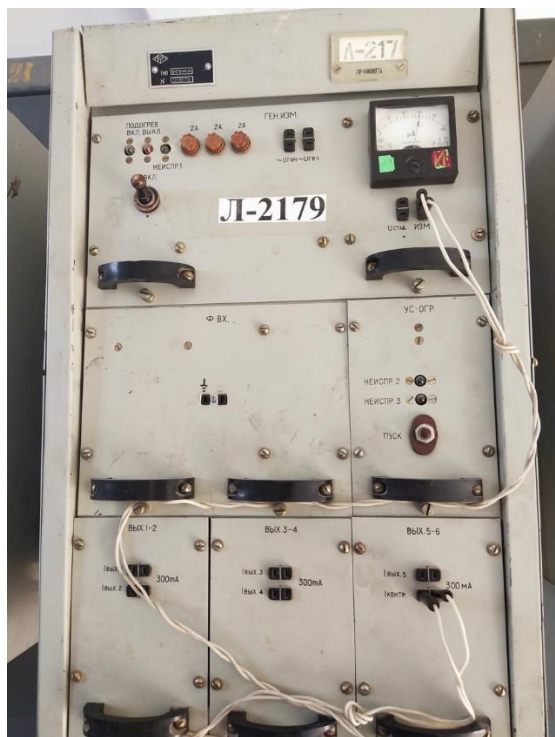
Рис. 4.2.3. Фото устройств ВЧ-связи по ВЛ 220 кВ на ПС 500 кВ Жамбыл
