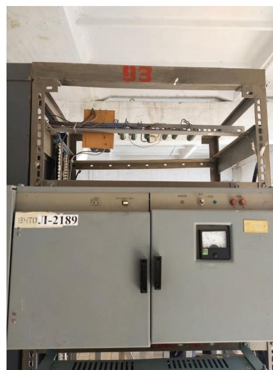
Рис. 4.2.3. Фото устройств ВЧ-связи по ВЛ 220 кВ на ПС 500 кВ Жамбыл
