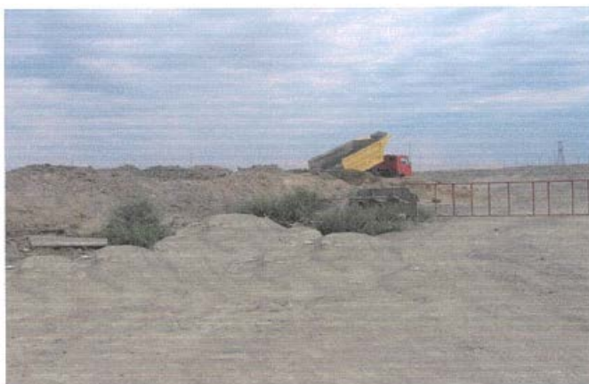
Фото 1. Склад для хранения глины
