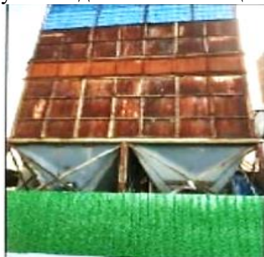
Сурет 4. Импульсті шаңды тазарту жүйесі.
