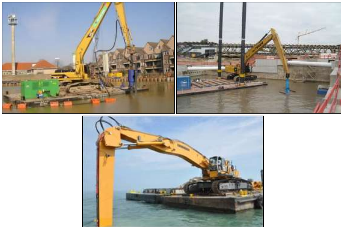
Рисунок 3.1.4 Механический земснаряд (МЗ) снизу, оснащенный ПЗС (слева) или грейферным ковшом (справа)
