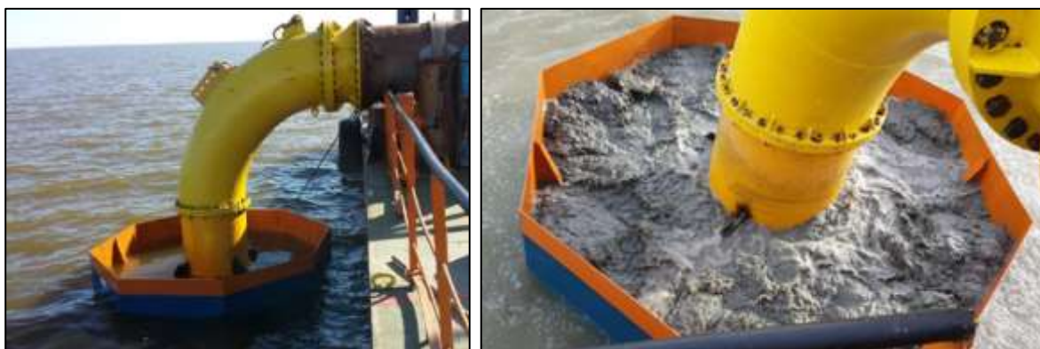
Рисунок 5.5.3 Технология «cooking pot» для затопленного сброса пульпы в море
