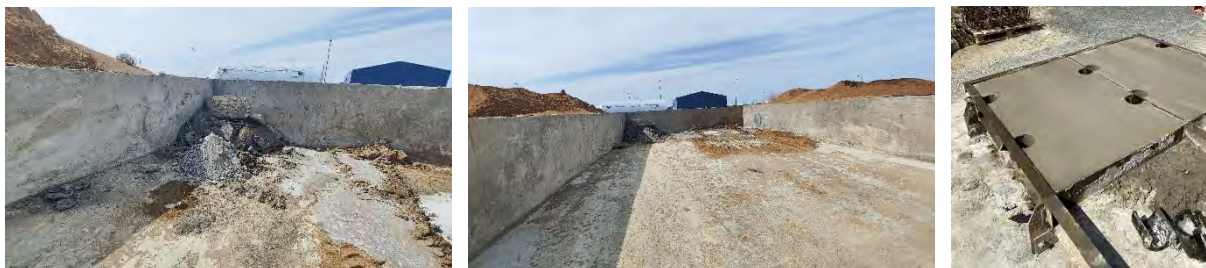
Фото 50 Площадка временного накопления отходов бетона на участке бетонного завода и базы гравия
