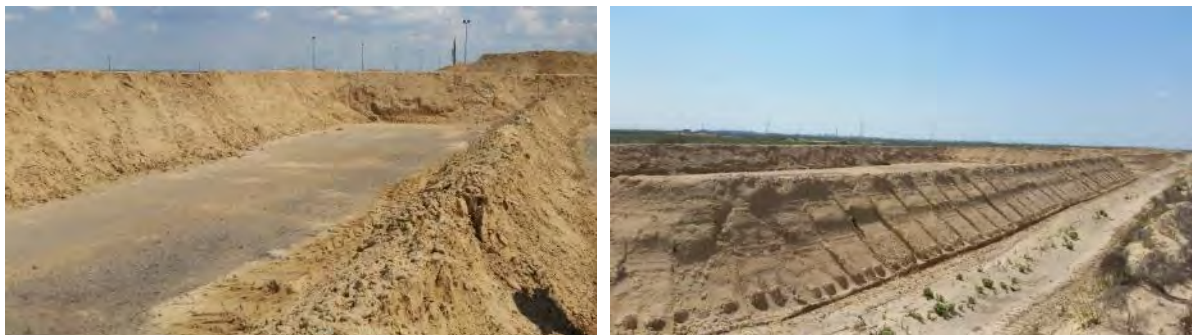
Фото 39 Площадка временного накопления потенциально пирофорных отходов на бывшей КВПП
