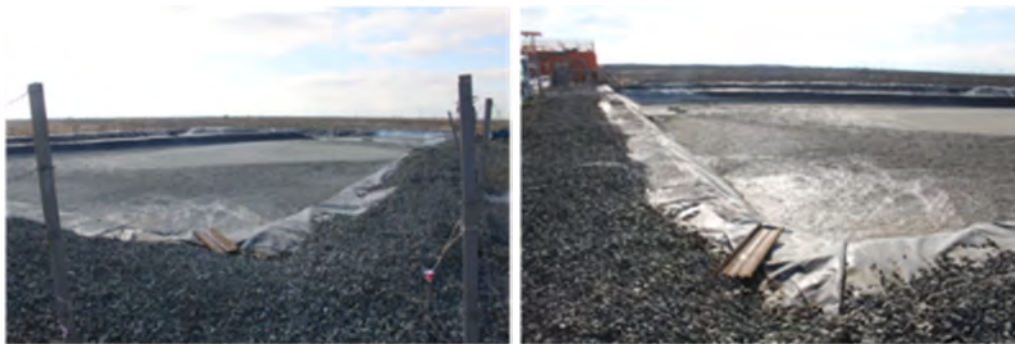
Фото 19 Общий вид участка хранения бурового шлама на водном основании
