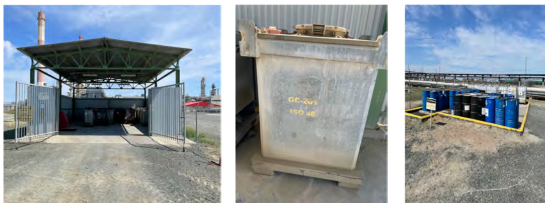
Фото 31 Площадка временного накопления жидких отходов химических материалов и отработанных масел на КТЛ (ХРХ)
