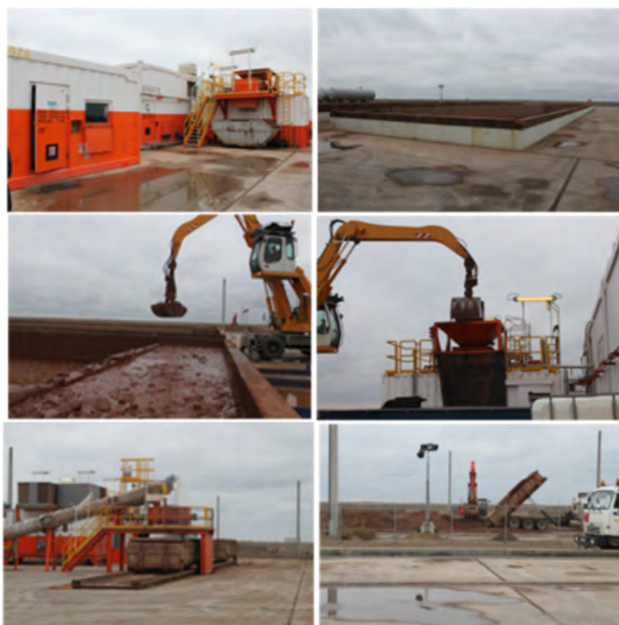
Фото 2 Процесс переработки шлама на ТСС
