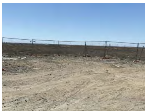
Фото 21 Секция для временного накопления отходов отработанных шин и резинотехнических изделий на ТЭЦ
