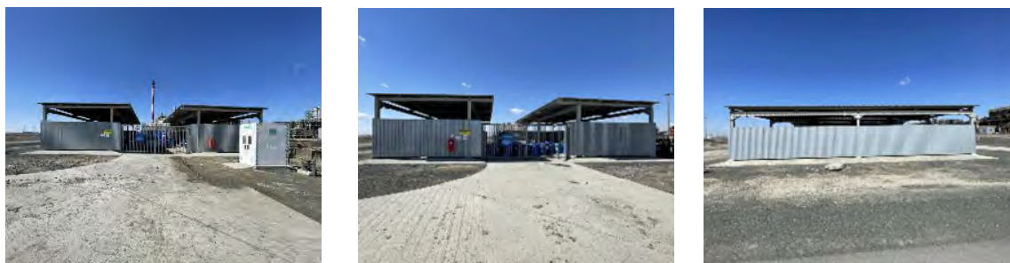
Фото 32 Площадка временного накопления жидких отходов химических материалов на ЗВП (ХРХ)
