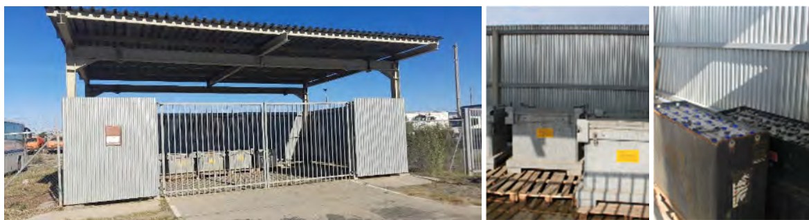
Фото 27 Площадка временного накопления для отработанных аккумуляторов на АРП-1
