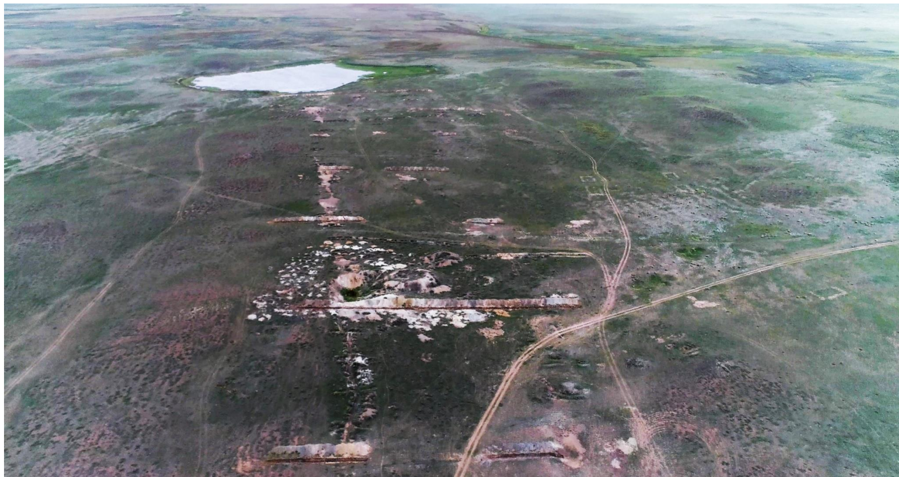
Фото 3. Вид с юга на центральный сектор участка Жуантобе.
