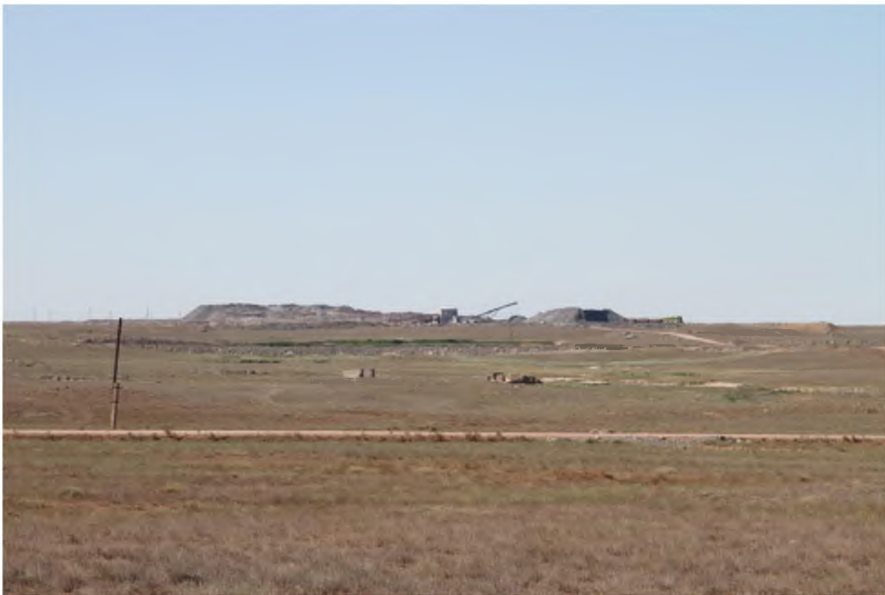
Общий вид с юго-запада. Территория угловых точек №№18-20
