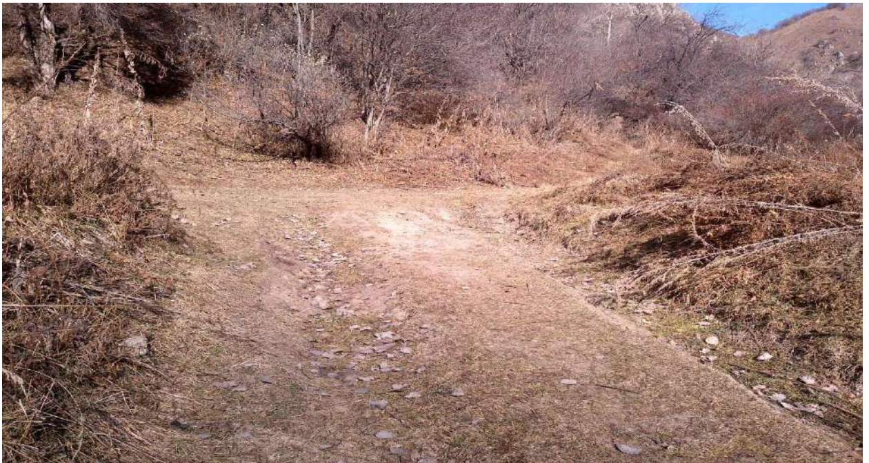
Фото 3.1.6.3.3 - Вид дорожной депрессии
