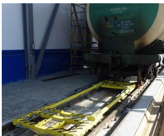
Фото 10. Здание «Промывочная станция»
