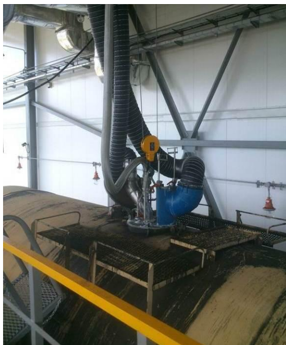
Фото 11,12 Установки моечных головок на люках цистерн компаний «Чистые технологии»
