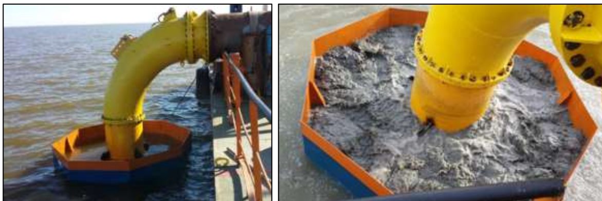
Рисунок 5.4.7 Технология «cooking pot» для затопленного сброса пульпы в море
