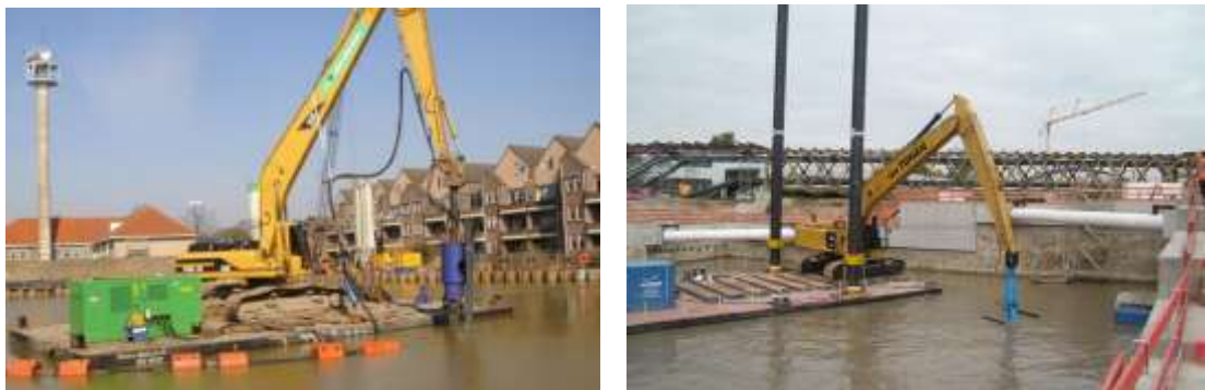
Рис. 3.6 Экскаватор на понтоне, оборудованный ПРН (слева) или грейфером (справа).
