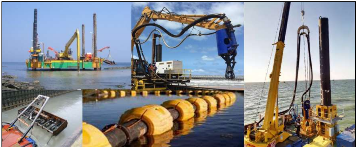
Рисунок 3.4 Мобильный кран на плавучей самоподнимающейся платформе с насосом DOP
