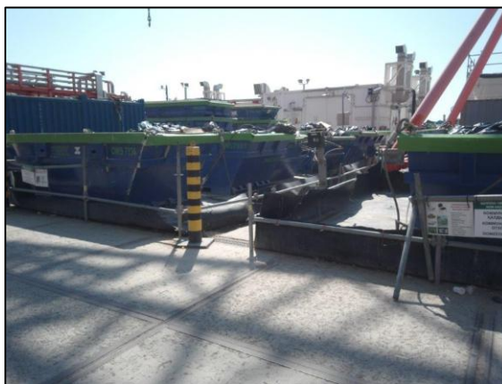
Фото 1 Площадка временного накопления отходов на острове Д
