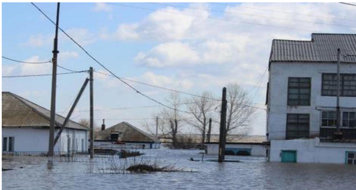
Фото 7-1 Подтопление домов в г. Атбасар
