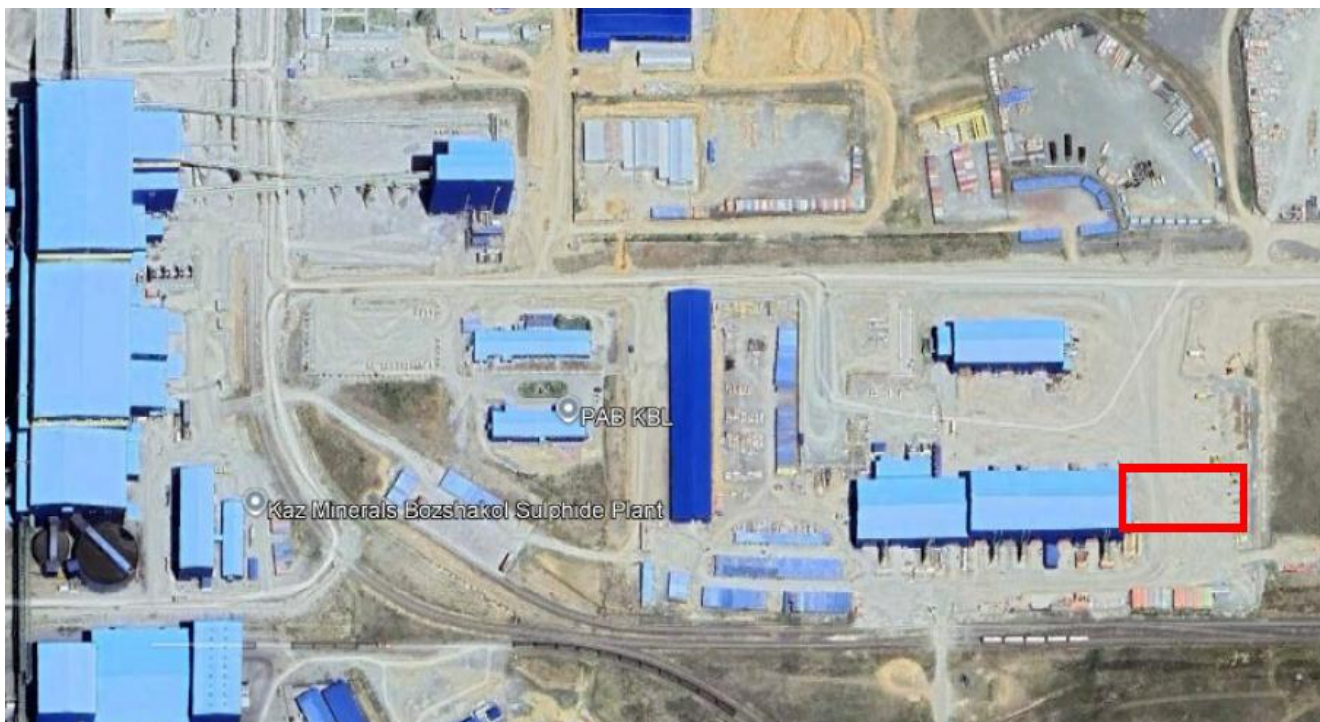
Рисунок 1 – Расположение участка проведения работ по расширению здания обслуживания горной техники на территории производственной площадки ТОО «KAZ Minerals Bozshakol»
