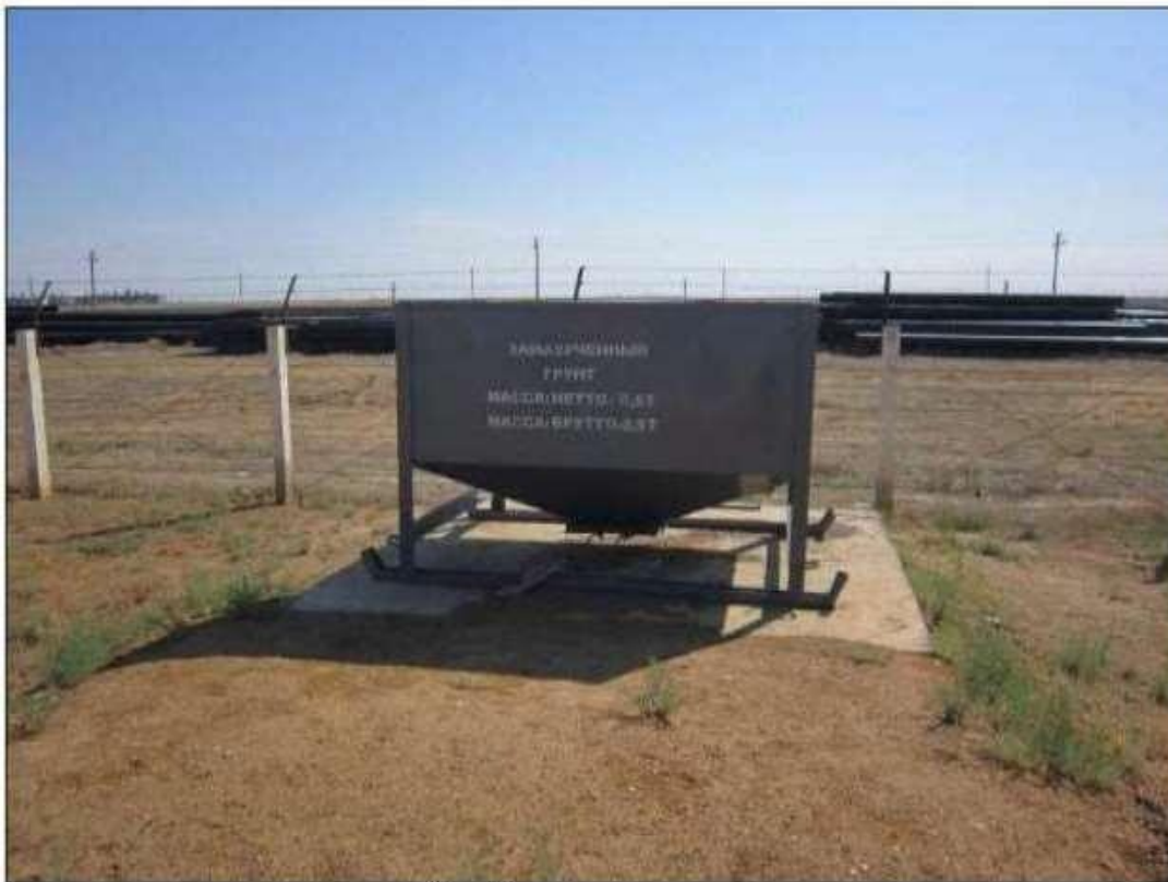
Фото 2.7. Ёмкость для замазученного грунта
