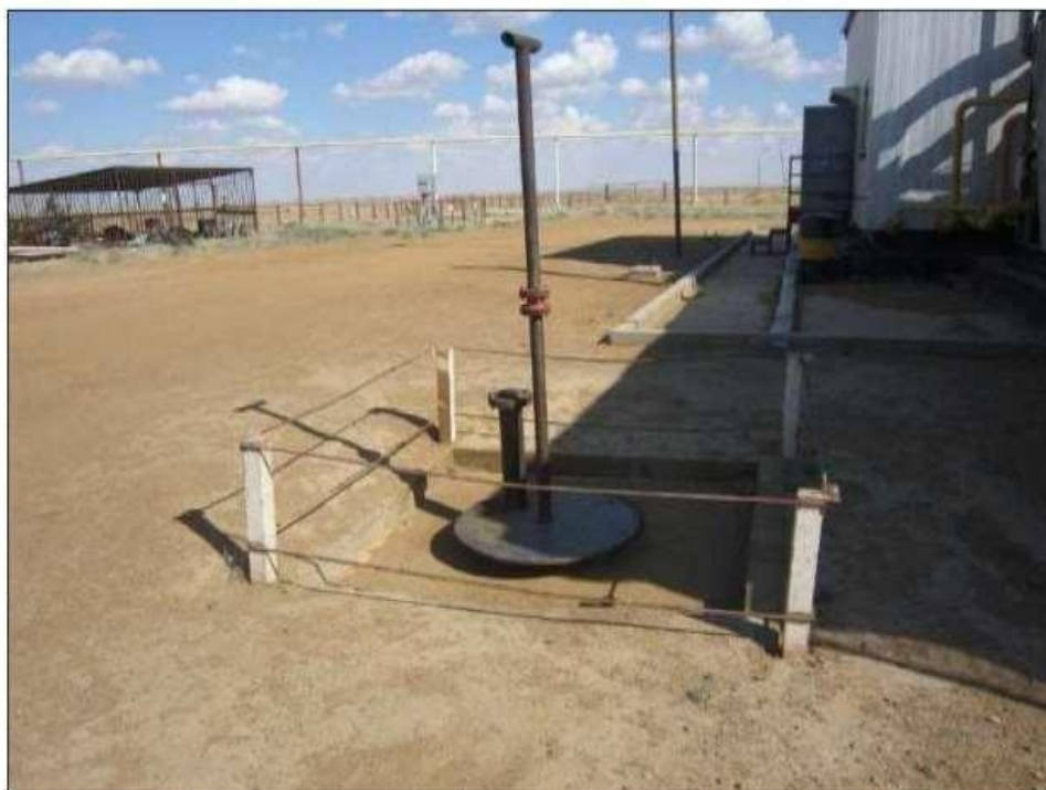
Фото 2.8. Подземная емкость временного хранения отработанного масла
