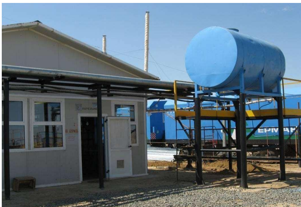
Рисунок 10. Резервуар запаса воды на хоз-бытовые нужды на ГСП
