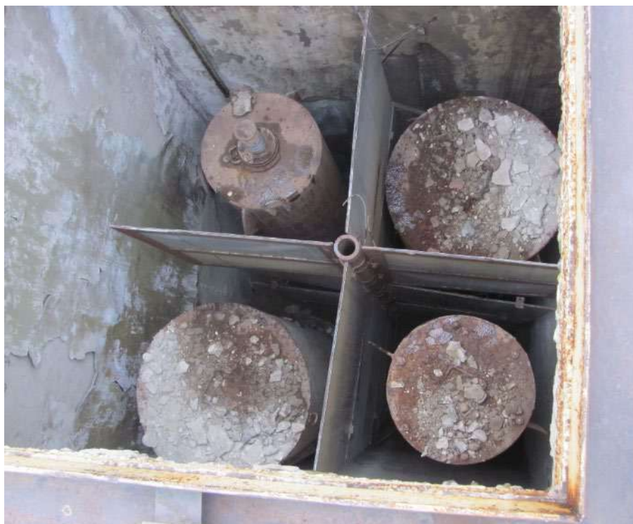
Рисунок 1 – Загрузочная шахта с контейнерами
