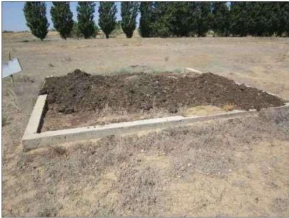
Фото 2.15. Площадка компостирования илового осадка на очистных сооружениях
