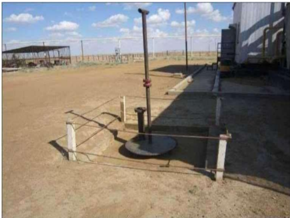
Фото 2.9. Подземная емкость временного хранения отработанного масла
