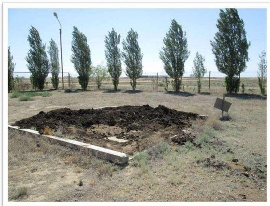
Фото 14. Площадка компостирования обезвоженных осадков
