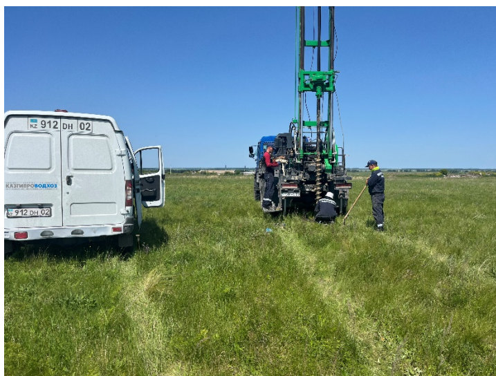
Рис. 3. Буровые работы на новых площадках строительства
