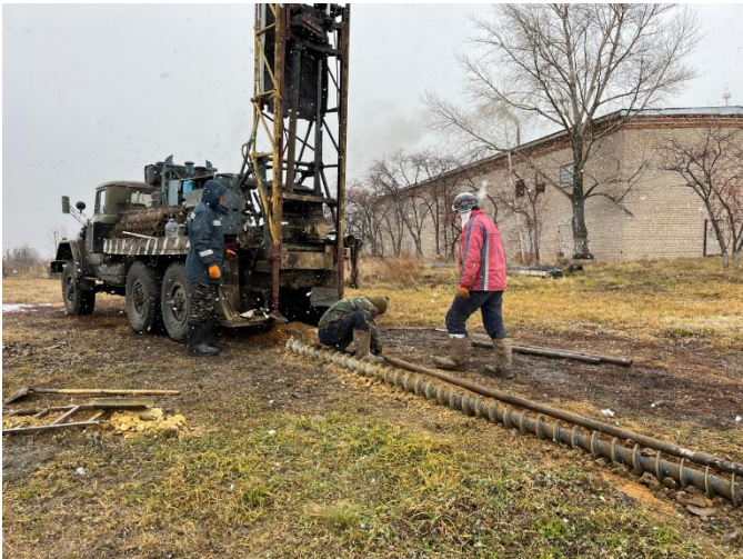
Рис. 1 Буровые работы на площадке
