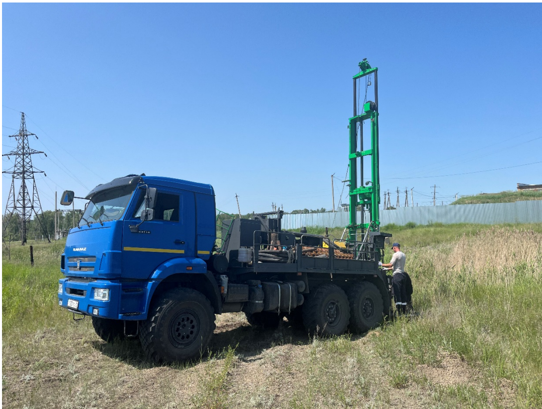
Рис. 4. Площадка подключения к существующему водоводу.
