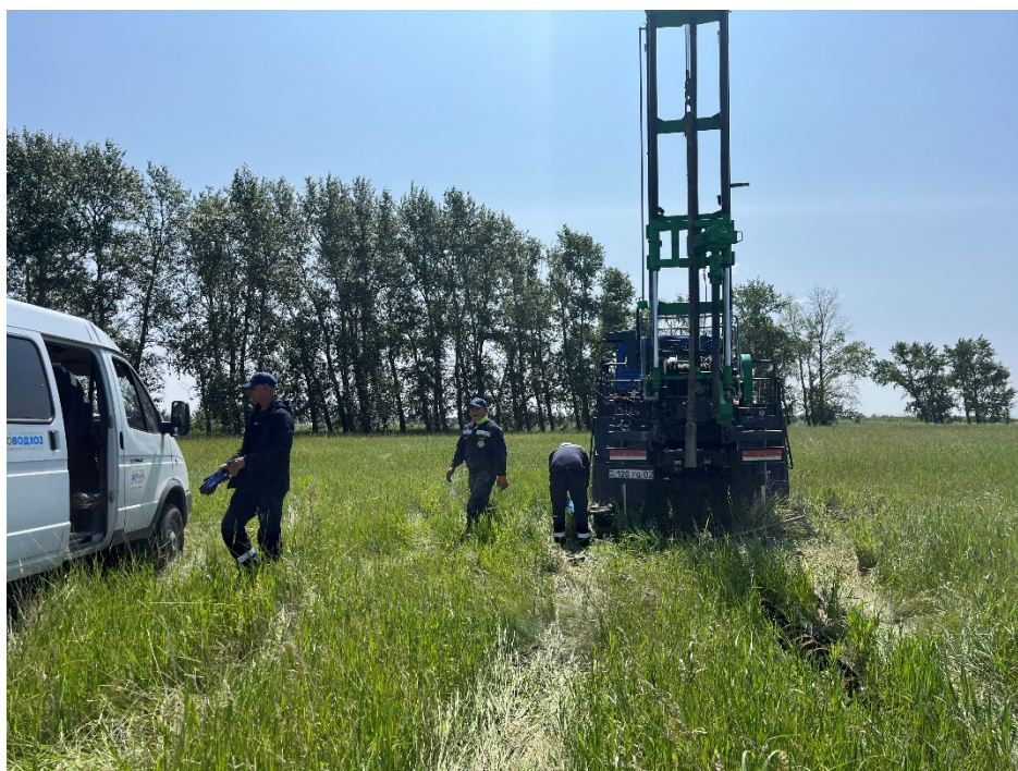
Рис. 4. Буровые работы на новых площадках строительства. Июнь 2025г.
