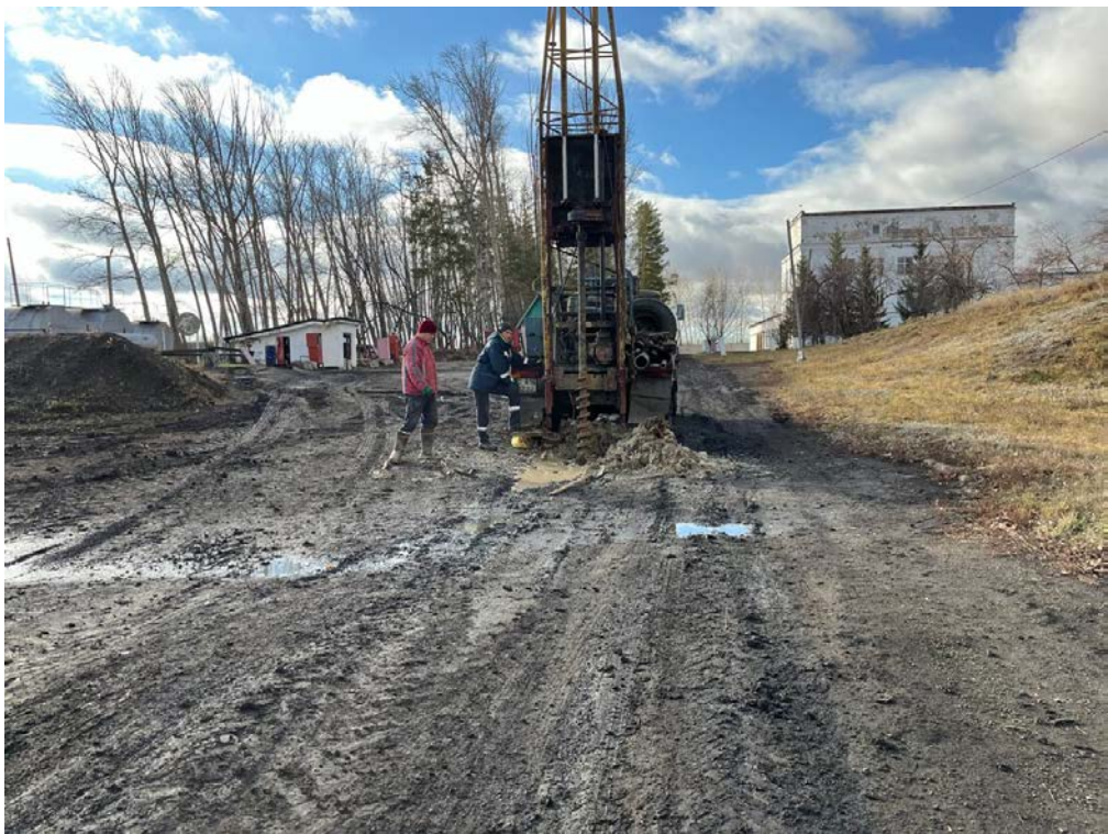
Рис. 1. Буровые работы на территории Ишимского ПУ
