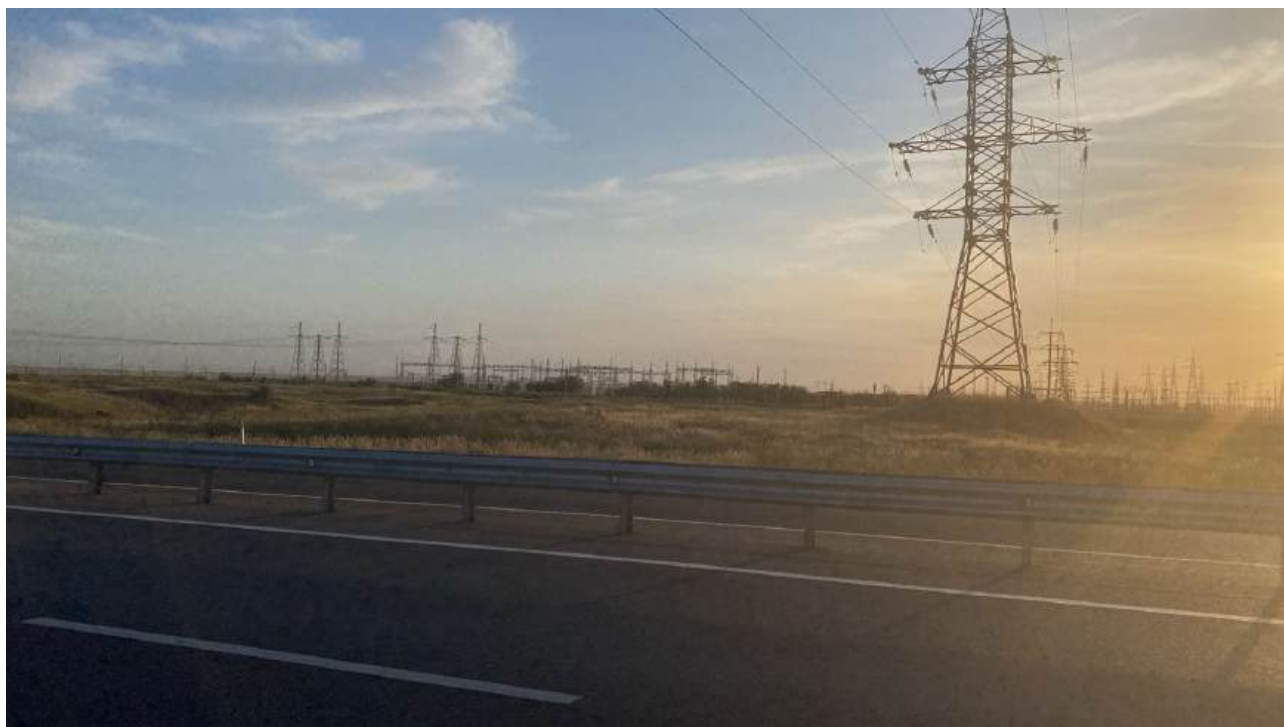
Начало ПС «Шу»
