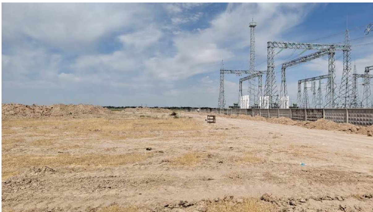
Рисунок 7.4. Растительность, нарушенная перевыпасом и механическими воздействиями у подстанции Шу
