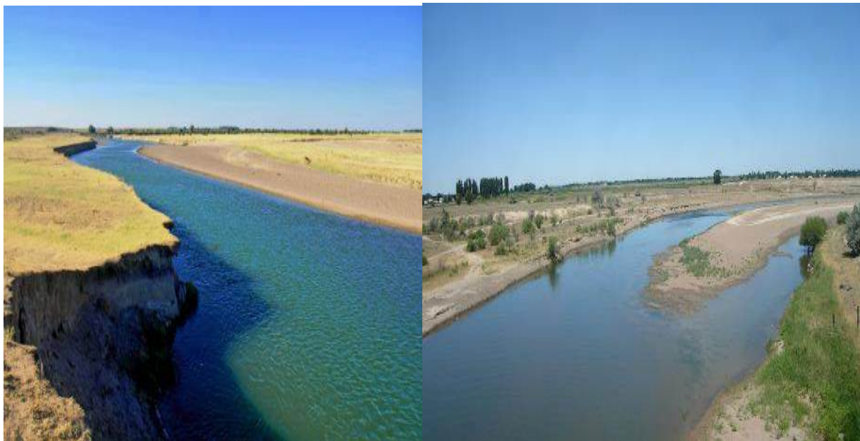
Рисунок 7.2. Долина реки Шу в точках пересечения реки ВЛ 500 кВ, идущей к подстанции Шу
