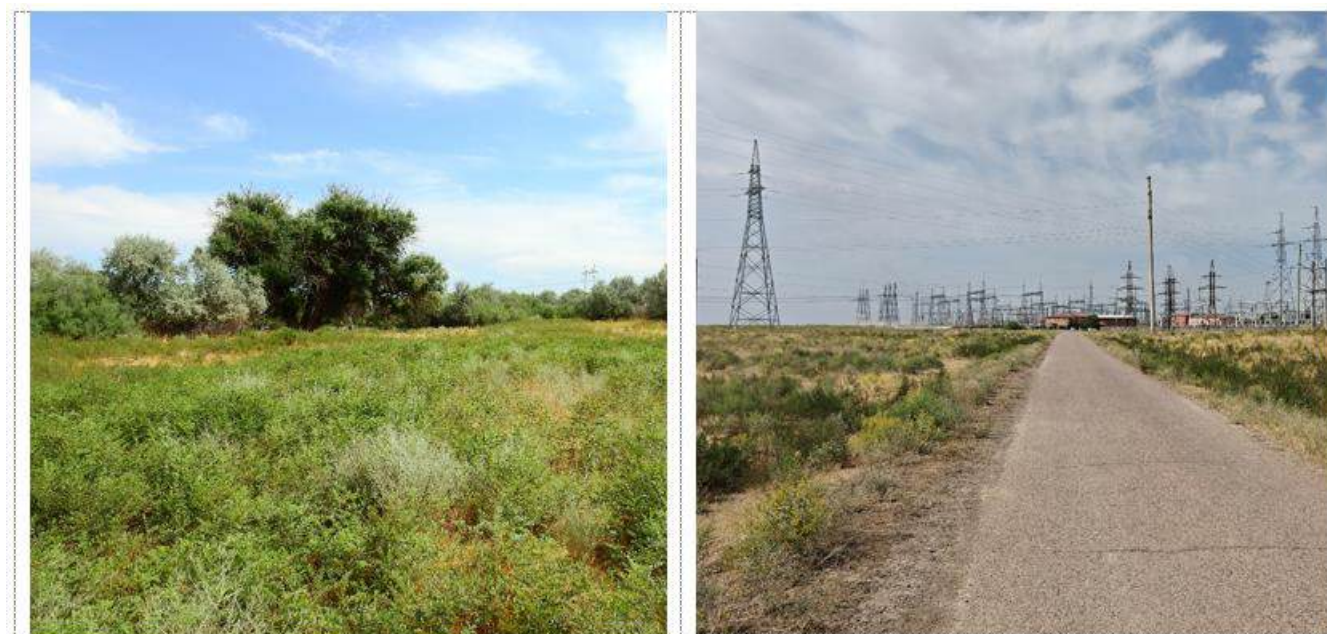
Рисунок 7.3. пойменный лес р. Шу на уровне подстанции и подстанция Шу
