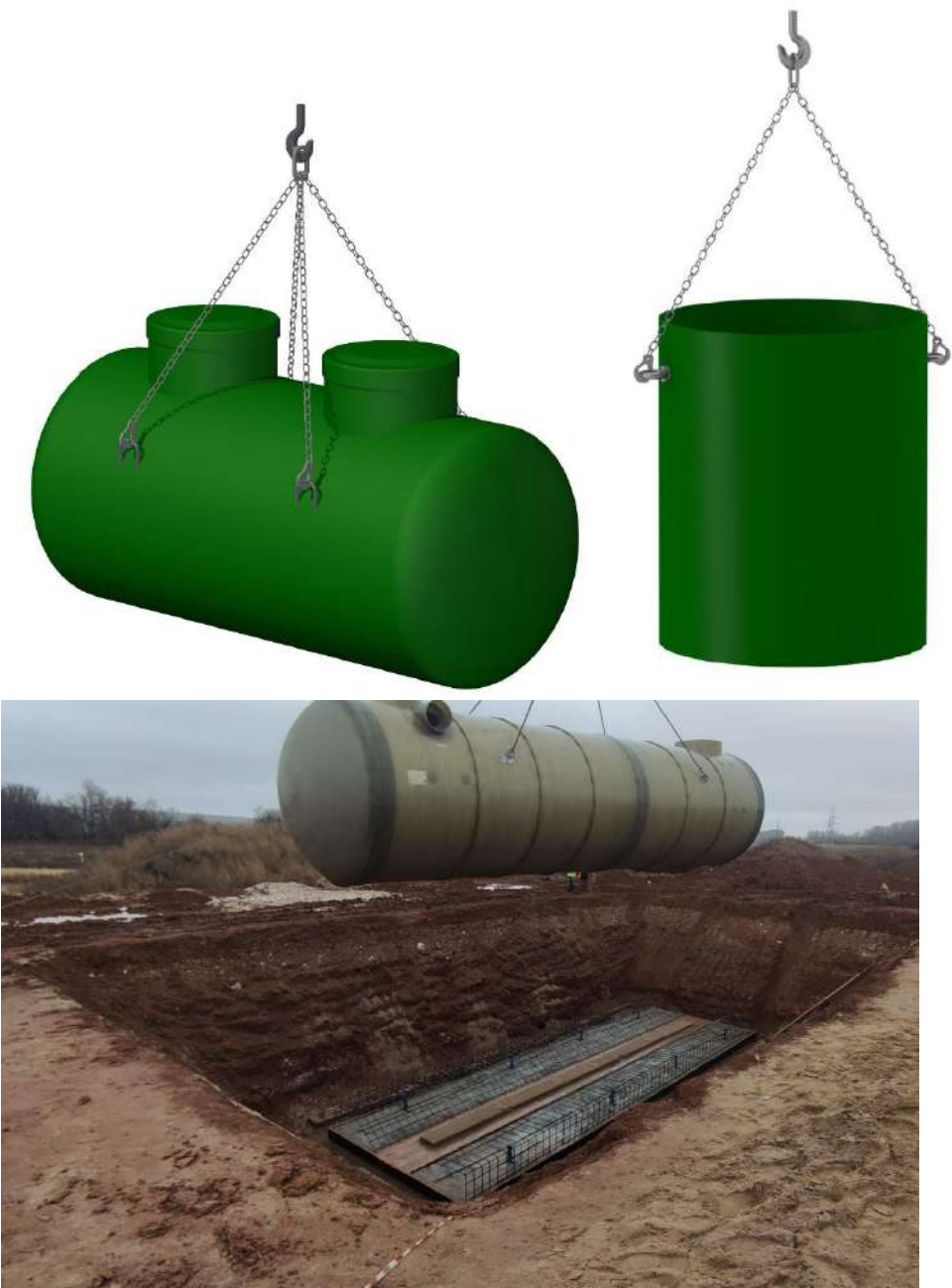
Рисунок 22 – Пример строповки элементов установки
