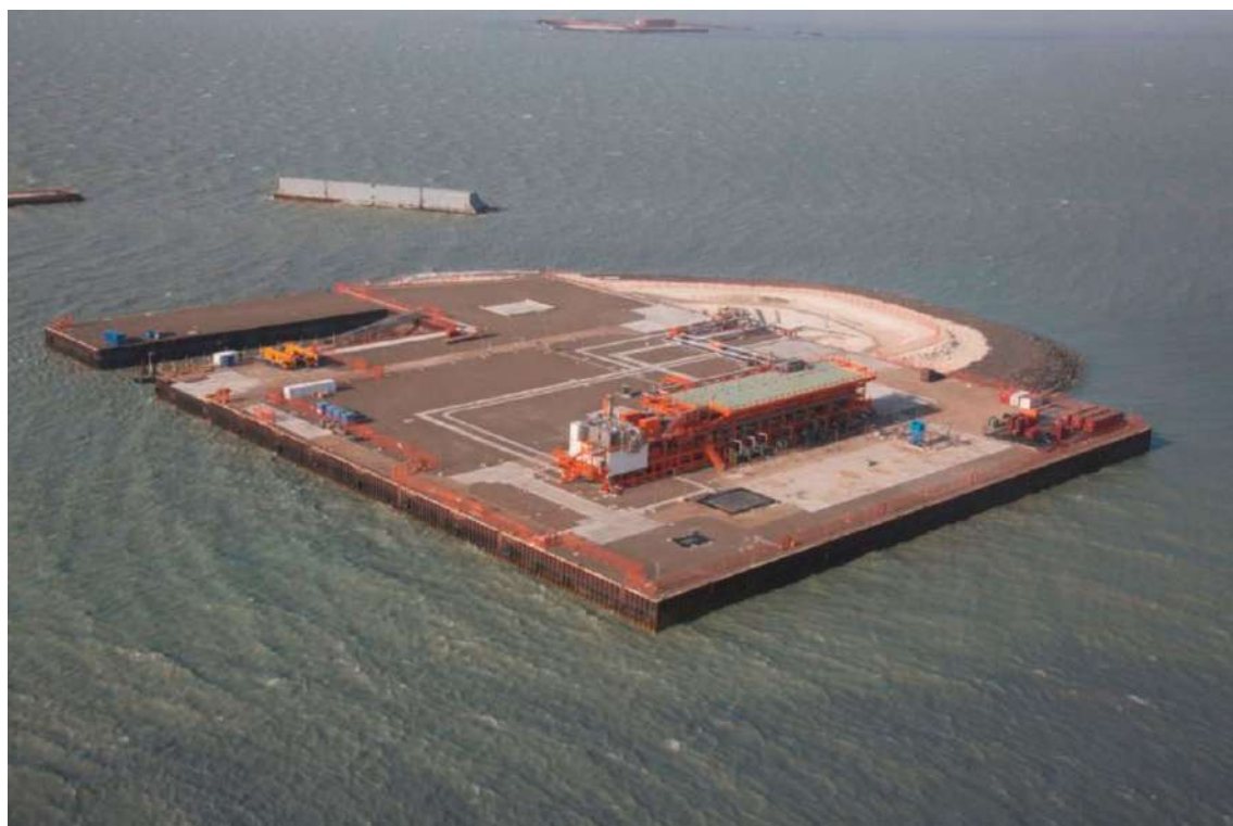
Рисунок 3.1.8 Остров ЕРС2. Общий вид
