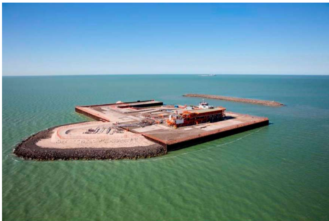
Рисунок 3.1.9 Остров ЕРС3. Общий вид
