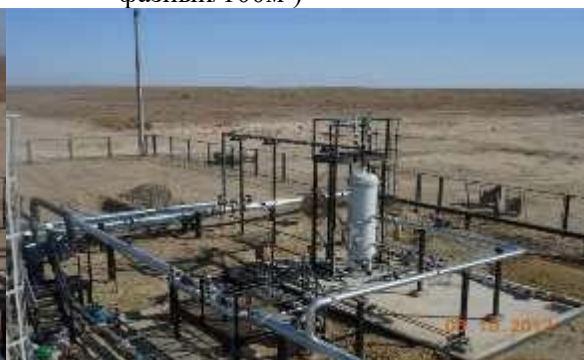
Рис.2.4-Вертикальный газовый сепаратор на ГУ
