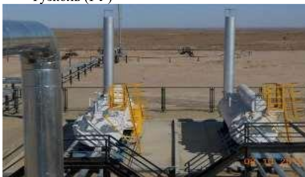
Рис.2.3 - Печи подогрева нефти.
