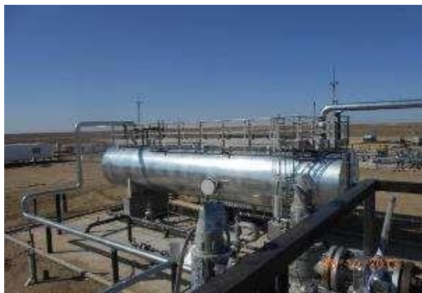
Рис.2.2 - Нефтегазовый сепаратор (3-х фазный/100м³)
