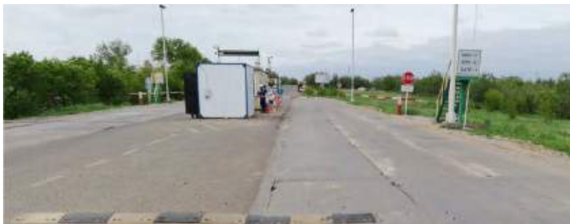
Рисунок 4. Контрольный пропускной пункт КПП-4 на ПК3+26.02
