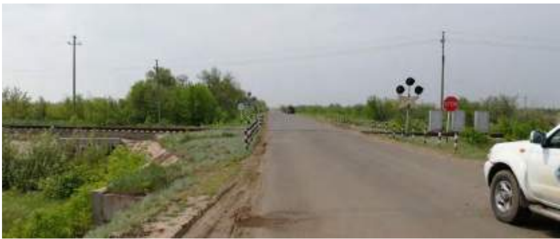
Рисунок 5. Железнодорожный переезд на ПК30+25.37
