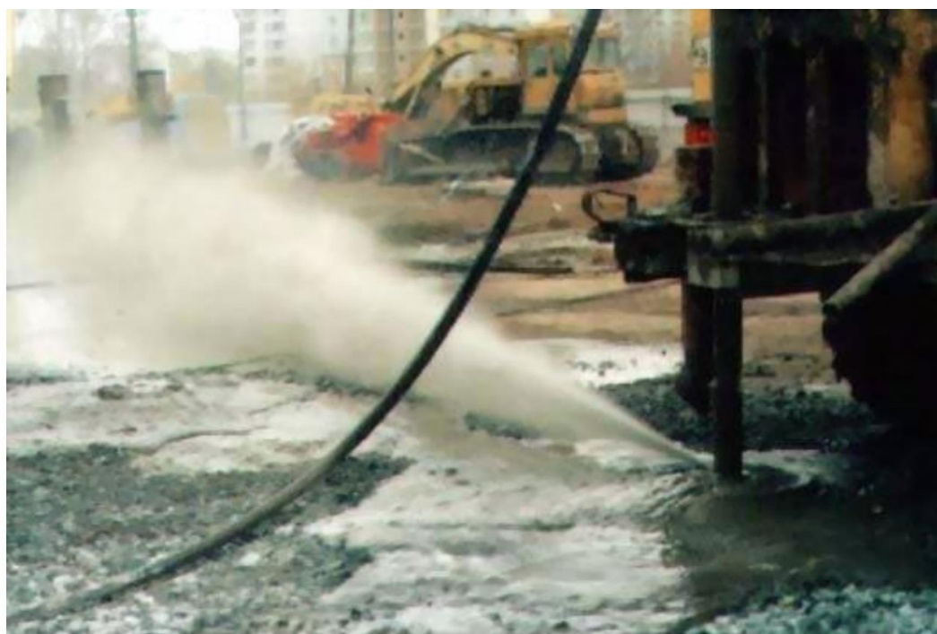
Рисунок 3.19 - Высоконапорная струя цементного раствора
