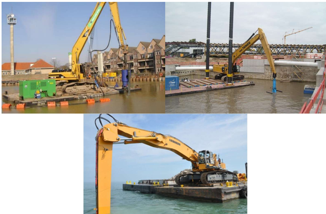
Рисунок 5.3 Механический земснаряд (МЗ) снизу, оснащенный ПЗС (слева) или грейферным ковшом (справа)
