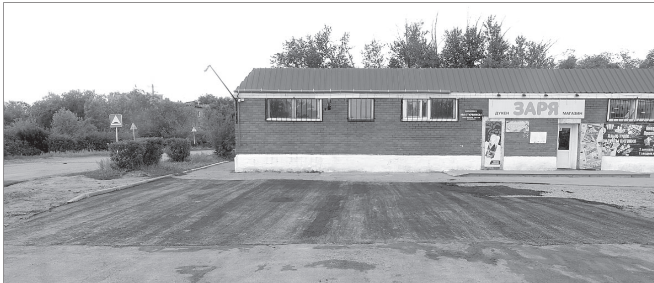
После замены аварийного участка канализационного коллектора ТОО «Рудненский водоканал» уложен новый асфальт
