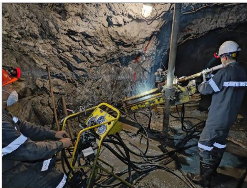
Рисунок 18. Установка Diates-232 и буровая бригада в буровой камере.
