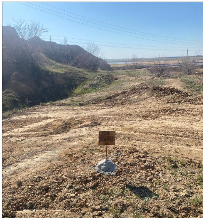
Рисунок 16. Скважина АКГ-05–01, пробуренная АТА и перекрытая стальной пластиной и цементом с указанием информации о ней.
