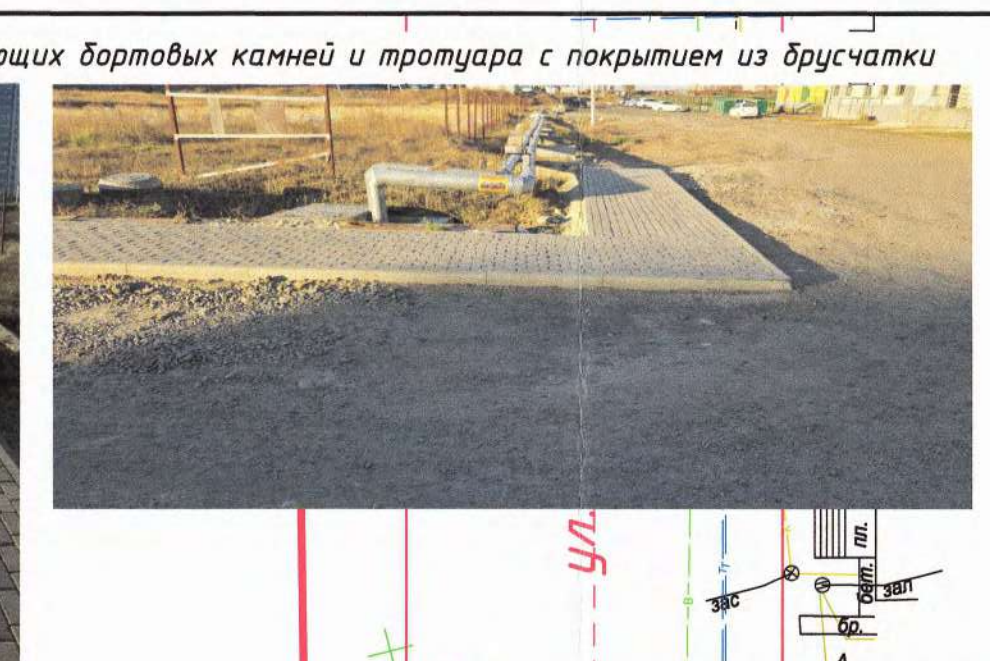
Демонтаж существующих бортовых камней и тротуара с покрытием из брусчатки
