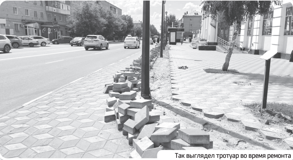
Так выглядел тротуар во время ремонта
