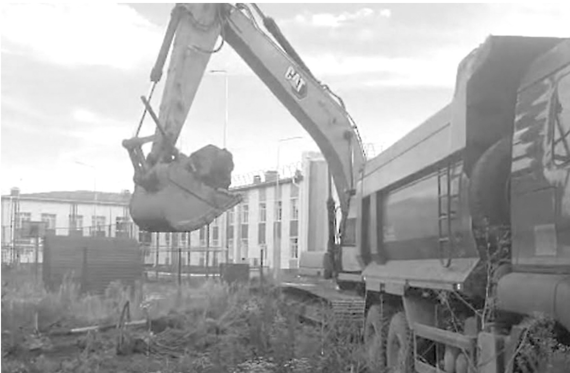
В Новой Бухтарме ликвидированы остатки бетонных изделий и строительного мусора
