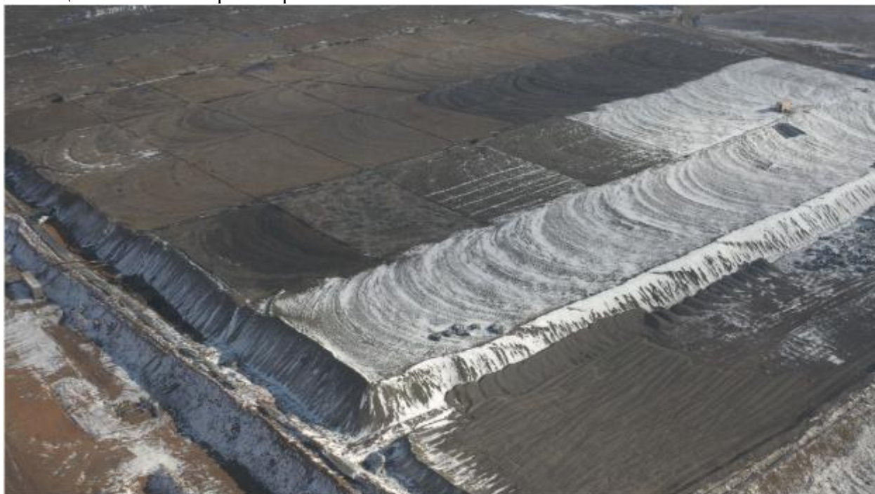
Фото 2. Участок кучного выщелачивания. Существующее положение.
