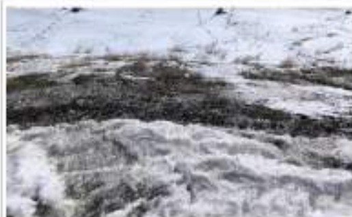
Фиг. 5. Следы вымывания снега с крыши здания
