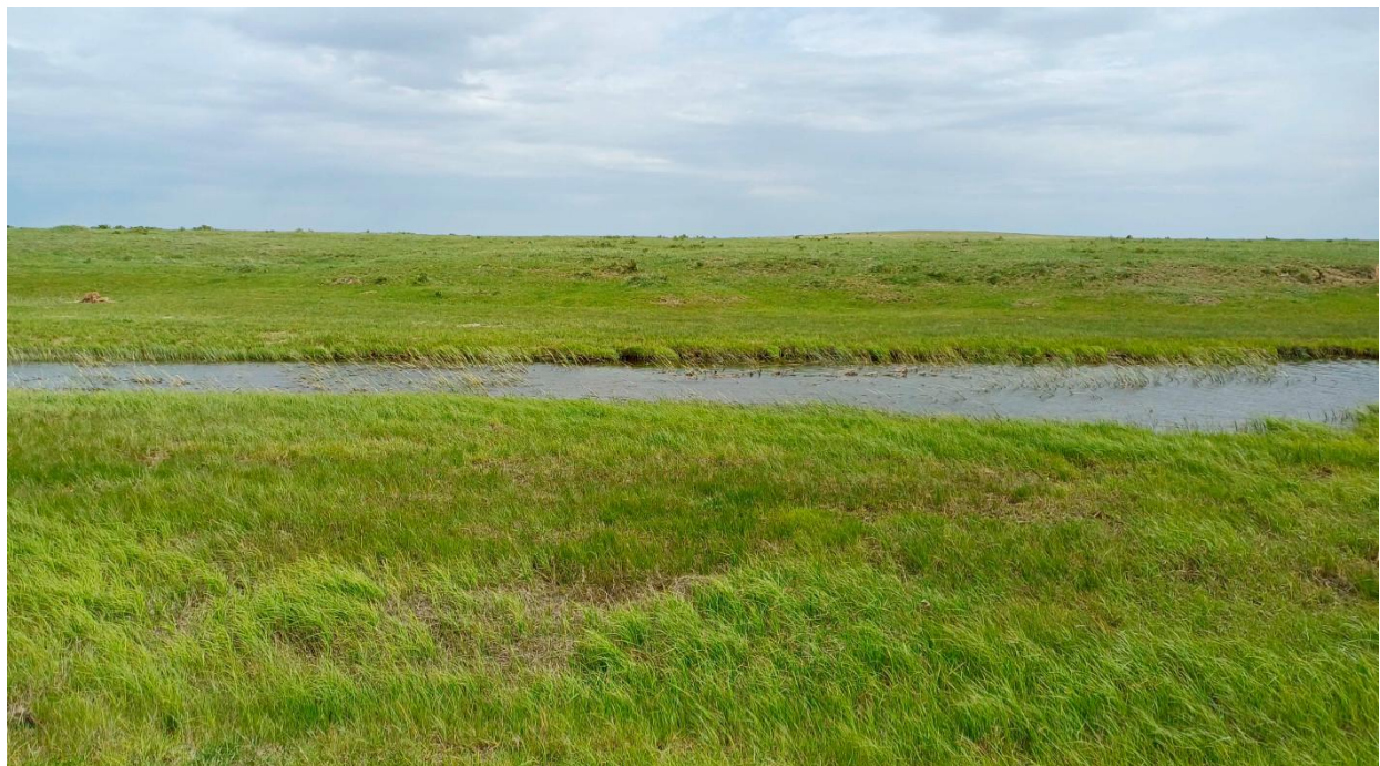
Рисунок 7.1. Река Орь в районе плотины водохранилища «Жамбыл»
