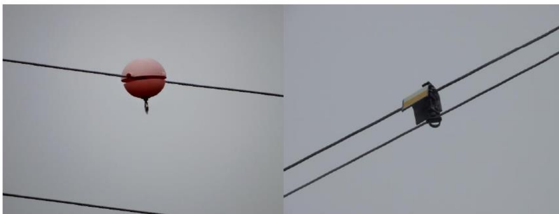
Рисунок 16 - Пример маркирующих устройств, предотвращающих столкновение птиц об провода
