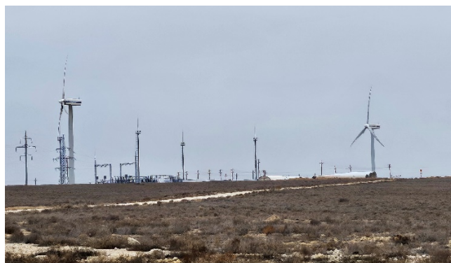
Фото 13.2. Ветровая электростанция мощностью 43,6 МВт
