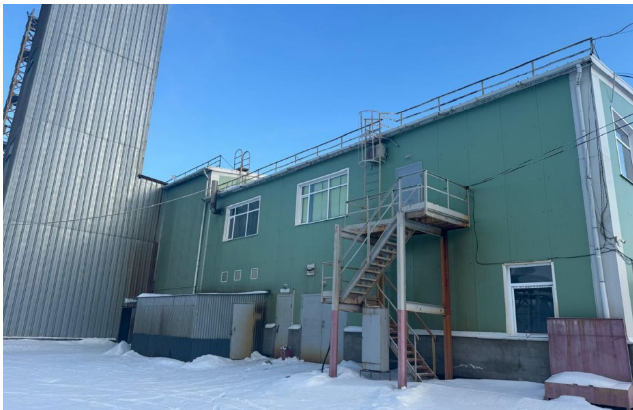
Рисунок 4 - Общий вид Фасадной части.
