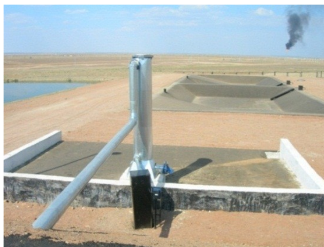
Устройство и принцип работы песколовки
