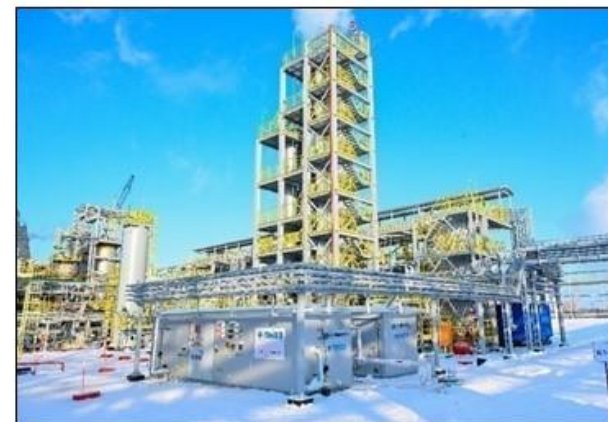
Установка очистки СУГ
