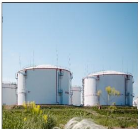
Установка понтонов на Р-1, 2
