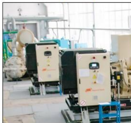
Замена компрессоров ВКС
