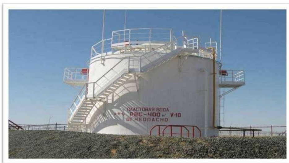
Фото 10. ЦППН. Резервуар пластовой воды объемом 400 м 3
