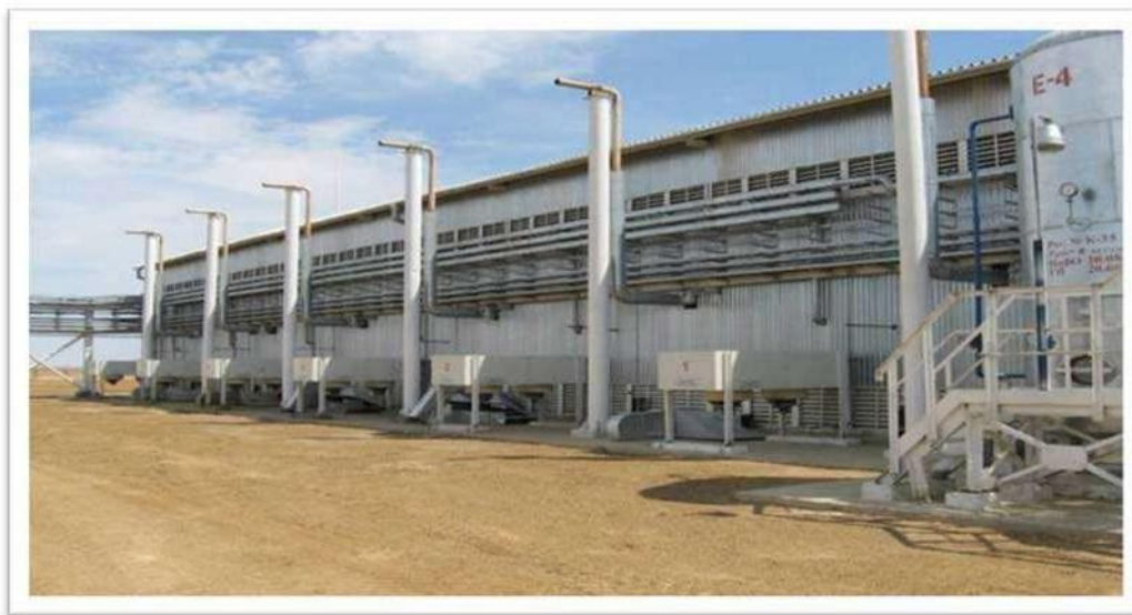
Фото 6. Компрессорный цех. Производственный корпус.
