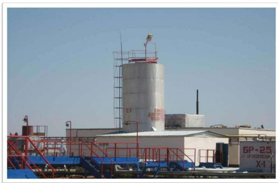
Фото 5. Резервуар запаса воды на технологические нужды
