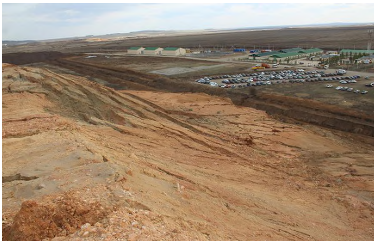
Рисунок 2.3.3 – Фотография выдавливания основания отвала вскрышных пород по юго-западной части по отметке +426,0 м, вид сбоку, ракурс на юго-восток.
