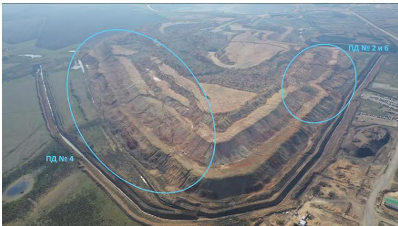
Рисунок 2.3.2 – Фотография участков трещин отрыва северной части отвала вскрышных пород, вид сверху, ракурс на восток
