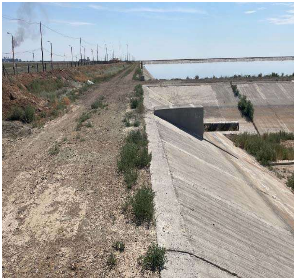
Рисунок 1 Внешний откос пруда-испарителя
