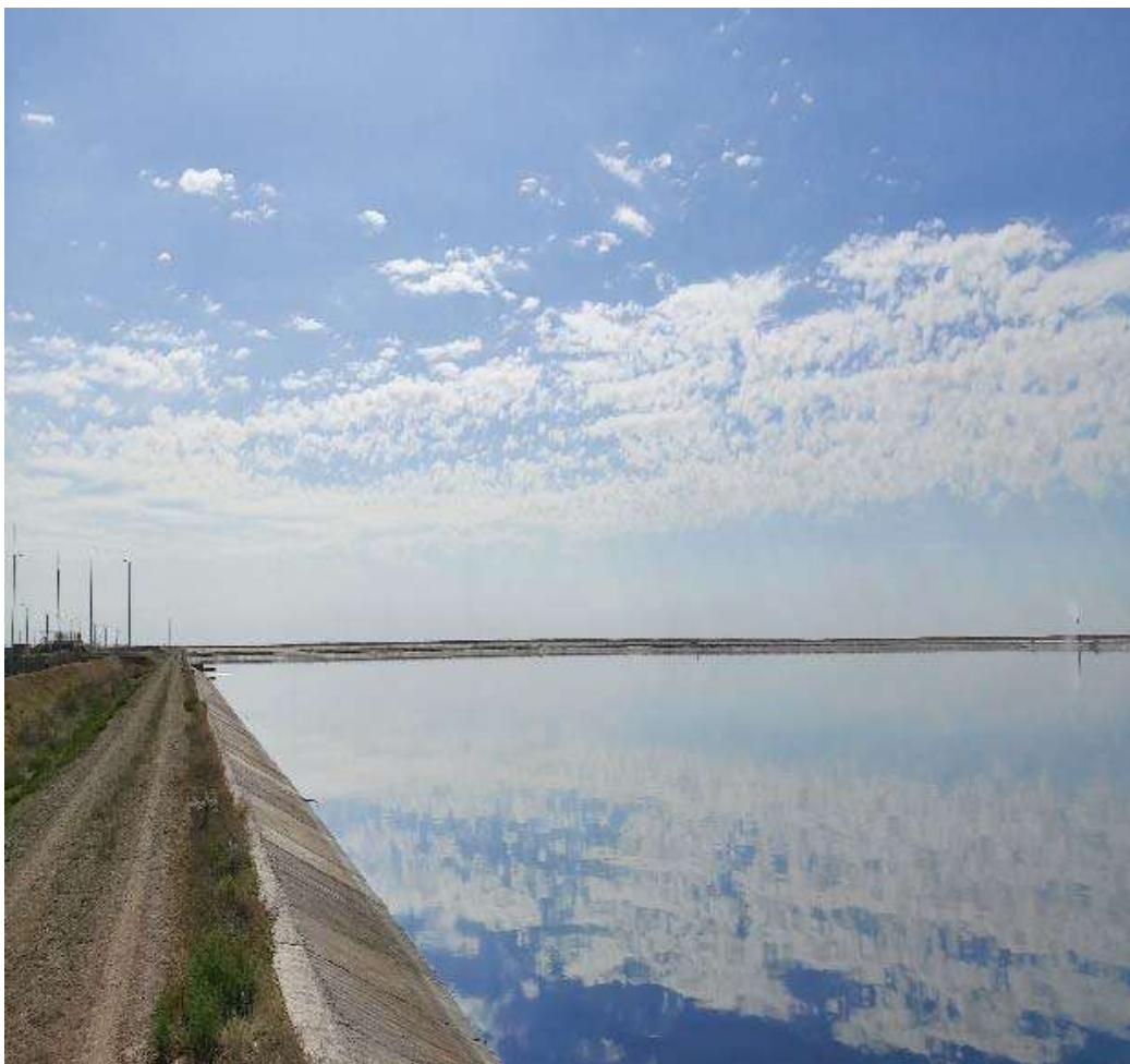
Рисунок 2 Подъездная дорога для специальной техники
