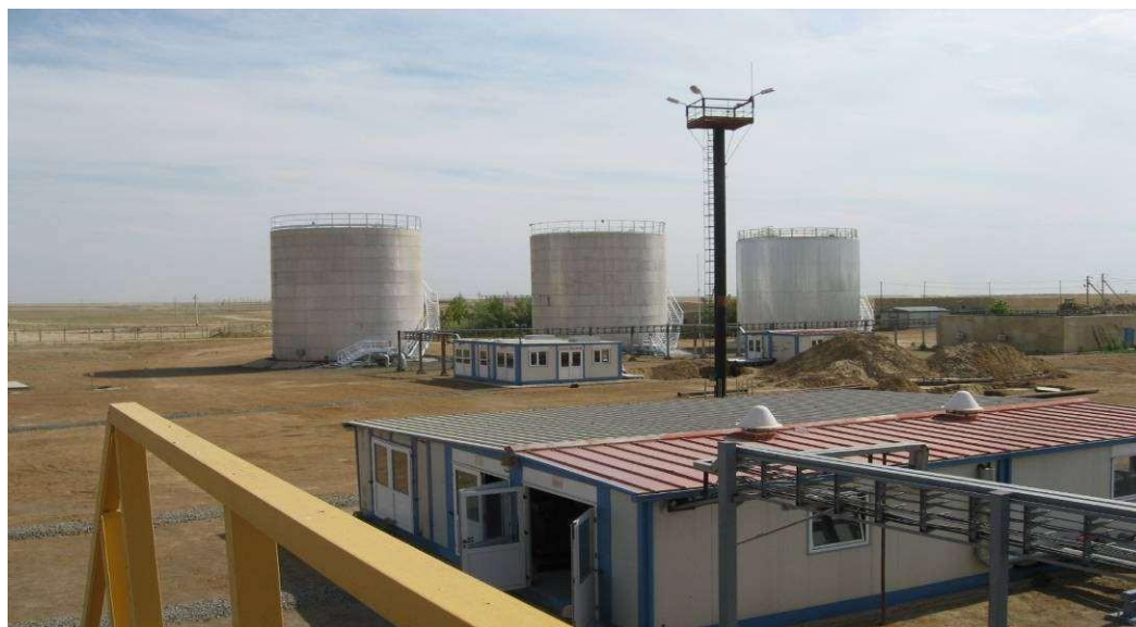
Рисунок 18. Резервуары запаса воды на хоз-бытовые и противопожарные нужды.
